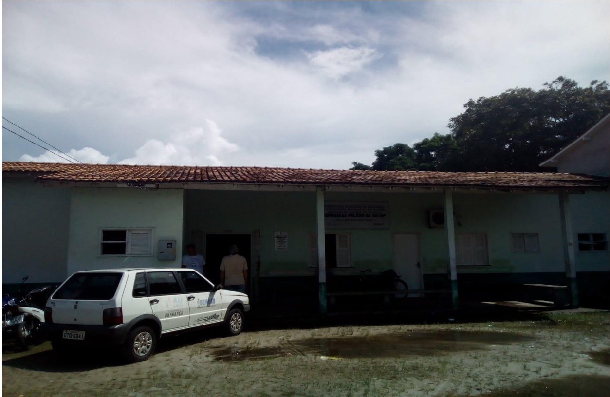
Reg. fotográfico da situação-Engenharia e Fiscalização/SEPLAN/PMB
