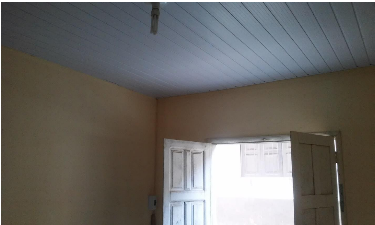
Reg. fotográfico da situação-Engenharia e Fiscalização/SEPLAN/PMB
