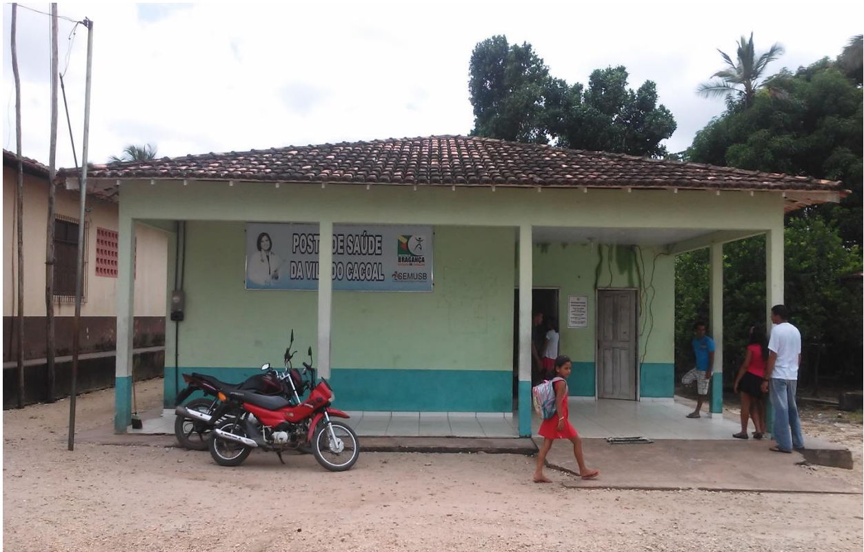
Reg. fotográfico da situação-Engenharia e Fiscalização/SEPLAN/PMB
