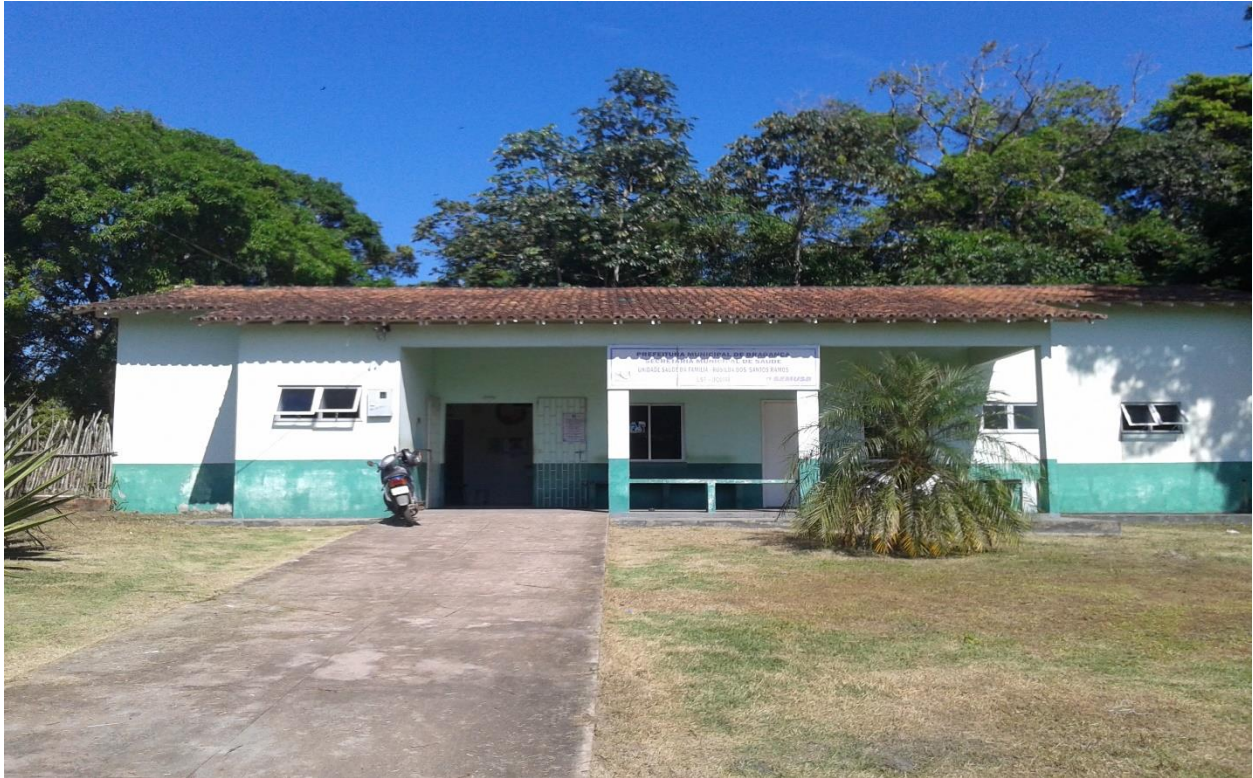
Reg. fotográfico da situação-Engenharia e Fiscalização/SEPLAN/PMB
