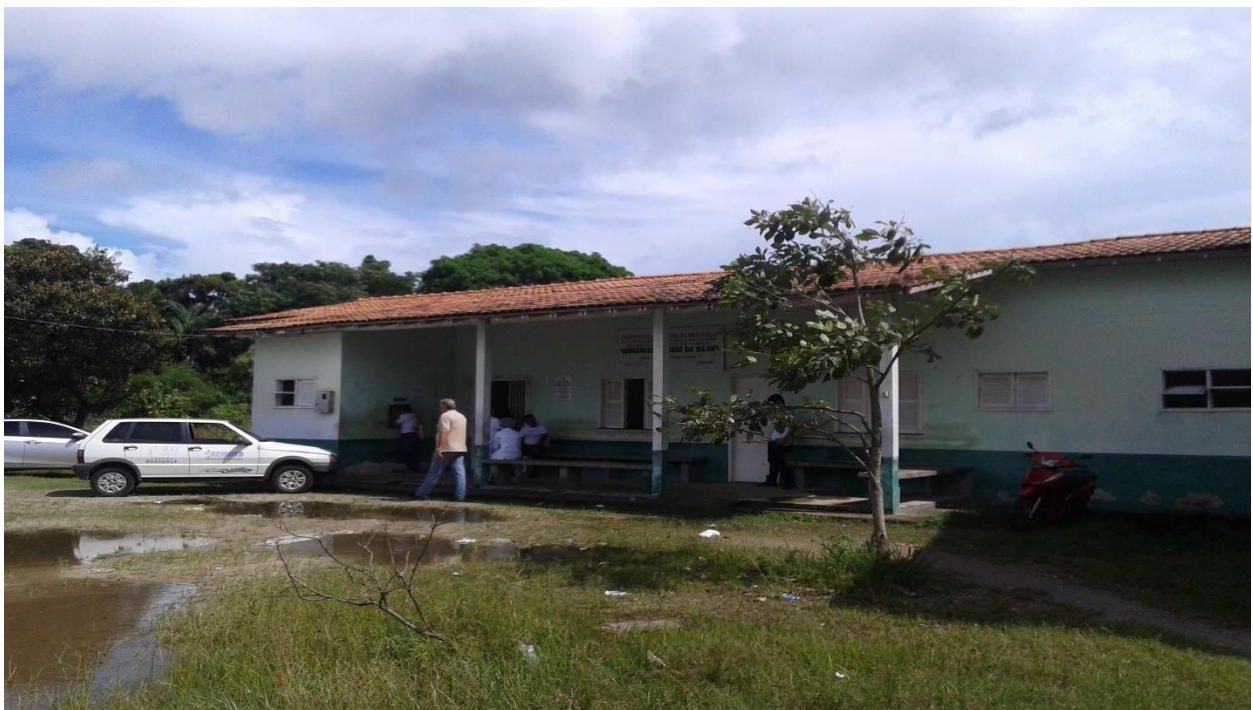
Reg. fotográfico da situação-Engenharia e Fiscalização/SEPLAN/PMB
